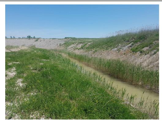
EROSION CHANNELS ALONG PERIMETER BERM AND STANDING WATER IN NORTH EAST DITCH
